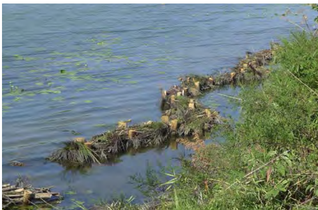
Mise en place de fascines Chemin nature
