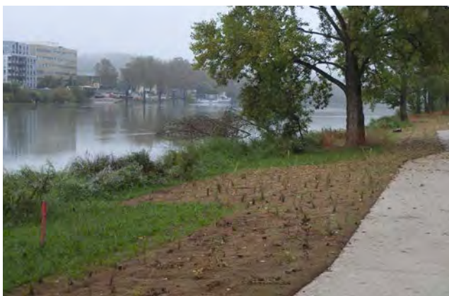
Mise en place de géonattes biodégradables Chemin nature
